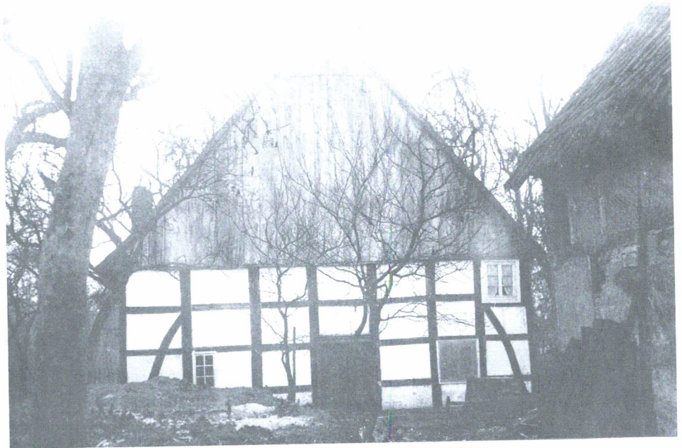
Altes Fachwerkhaus an der Ecke Kirchstraße/Meßdornstraße
